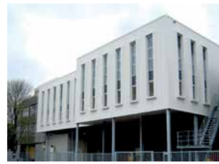
Friesland Campina | Ede Încălzire Acoperiș 1275 m 2 Cablu MAGNUM Outdoor
